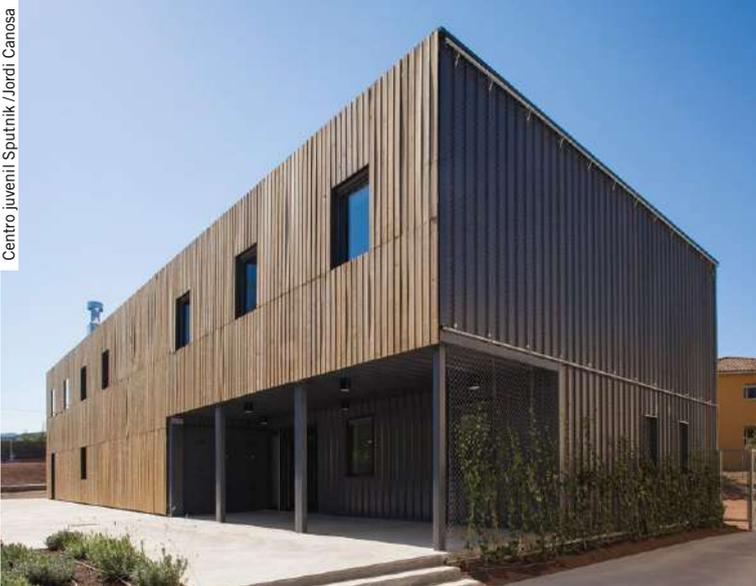
tinuo debido a la diferencia de temperatura entre el exterior y el interior. Esto hace que se reduzcan la condensación y las humedades, a la vez que se disminuye el calor que entra en el edificio en verano, así como el que sale del mismo durante el invierno.
