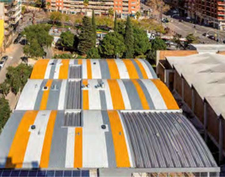
Las cubiertas autoportantes se han convertido en los últimos tiempos en una alternativa singular y atractiva para la edificación. El sistema se fundamenta en la doble capacidad que la cubierta presenta, ya que por sus prestaciones mecánicas es capaz de conformar la estructura y la envolvente del edificio. Con este tipo de sistema estructural se resuelven además aspectos tan importantes de una cubierta como la estanqueidad, la acústica, la protección térmica o la resistencia al fuego.
