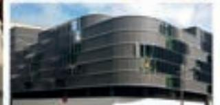
Frontek, la nueva generación de fachadas ventiladas y aplacadas realizadas en cerámica tecnológica extrusionada, que destaca por sus excelentes cualidades técnicas, ligereza, fiabilidad y fácil colocación. Su exclusivo diseño garantiza una fijación óptima a la estructura sin necesidad de realizar perforaciones o cortes que pudieran debilitar su resistencia.
