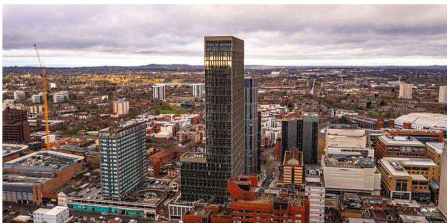
Siguiendo con las directrices de sostenibilidad y eficiencia que impregnan todo el proyecto, para reducir la energía incorporada, minimizar el desperdicio y ofrecer una máxima calidad en un sitio restringido del centro de la ciudad, la fachada se construyó con poco más de 3.600 paneles unificados, así como muchas otras de las unidades de trabajo clave, incluyendo el baño y las zonas de servicios públicos, que se beneficiaron de un montaje prefabricado con fabricación externa.
