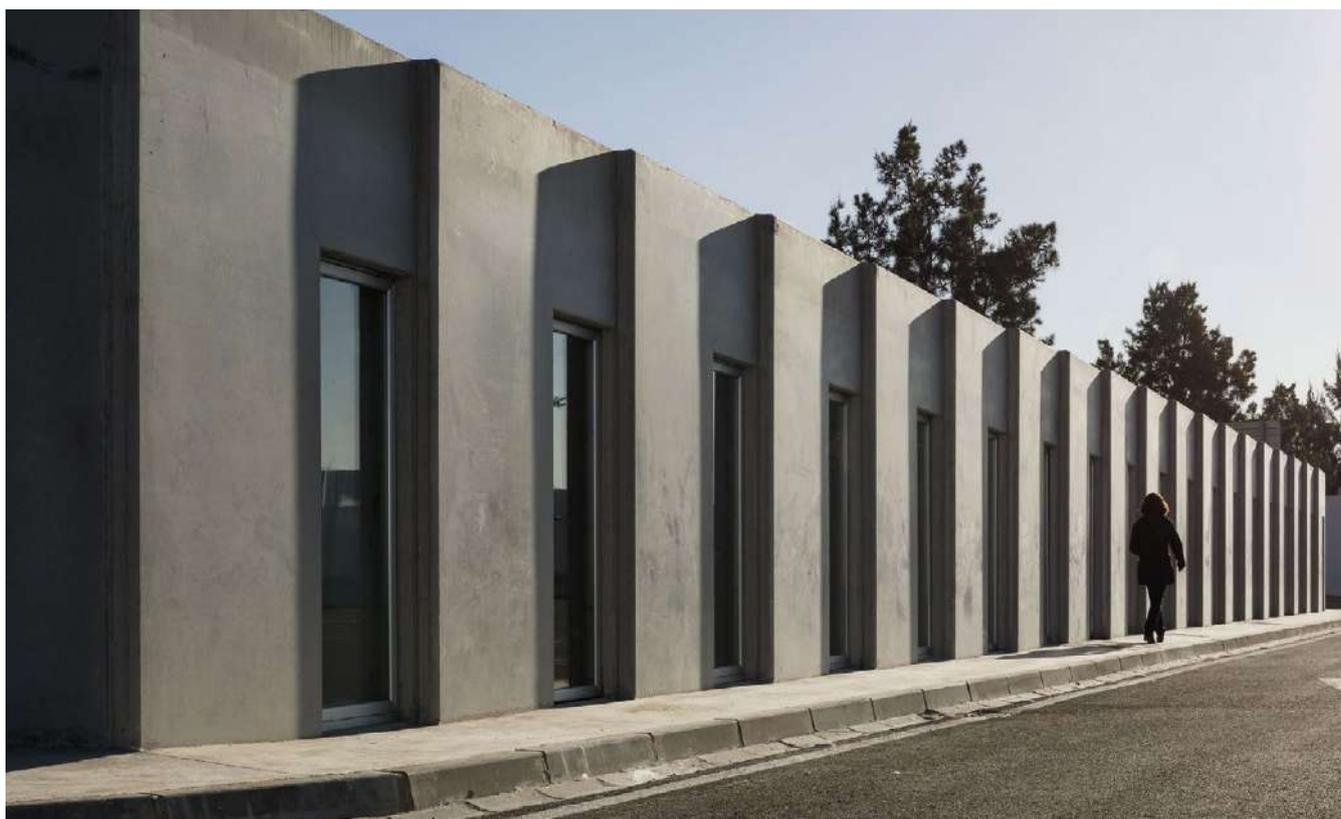
Principalmente se empezó a diseñar un panel que pudiera ser estructural y envolvente, para que la construcción de un prototipo se pudiera replicar resolviendo otras necesidades del puerto y, por extensión, en otros entornos marinos. Fue así como los nuevos edificios transitorios del puerto de Motril se construyeron con un sistema de paneles de hormigón prefabricado con armado de fibras, concretamente MasterFiber 246 y MasterFiber 400, de Master Builders Solutions.
