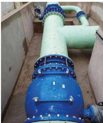
válvula de paso anular de nueva generación de Saint-Gobain PAM es idónea para aplicaciones de regulación y control, tanto de presión como de caudal, en los mercados de agua potable y riego. Esta innovación en regulación es posible gracias a su diseño hidrodinámico y cuerpo compacto de una sola pieza, que permite un paso de grandes caudales en la válvula manteniendo un nivel mínimo de pérdidas de carga, a la vez que se adapta a las necesidades operacionales del sistema.
