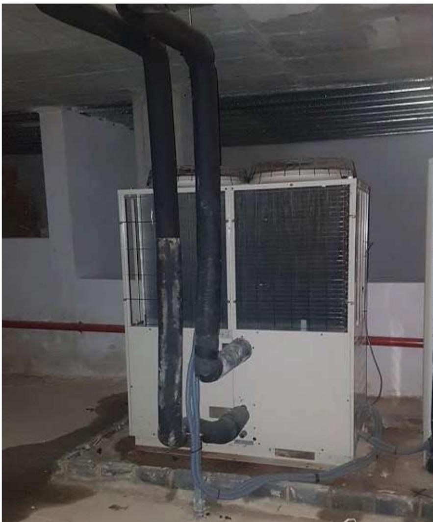
hasta 90 °C utilizando el refrigerante ecológico CO<sub>2</sub> y la tecnología Inverter. Para suministrar agua caliente sanitaria a una demanda diaria de unos 7.790 litros, se ha instalado un módulo Q-TON de 30 kW. El equipo Q-TON calienta los 3.500 litros de acumulación previstos para el ACS.
