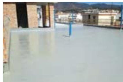
con resina mejoradora Cryladit, con una carga de 3 Kg /m.l y aplicación, sobre la superficie de mortero impermeabilizante cementoso hidráulico Tecmadry F, aditivado con resina mejoradora Cryladit, con una carga de 3 Kg/m<sup>2</sup>, aplicado en varias manos, que es apto para impermeabilizaciones tanto a favor como contra presión, previa limpieza del soporte por medios manuales.
