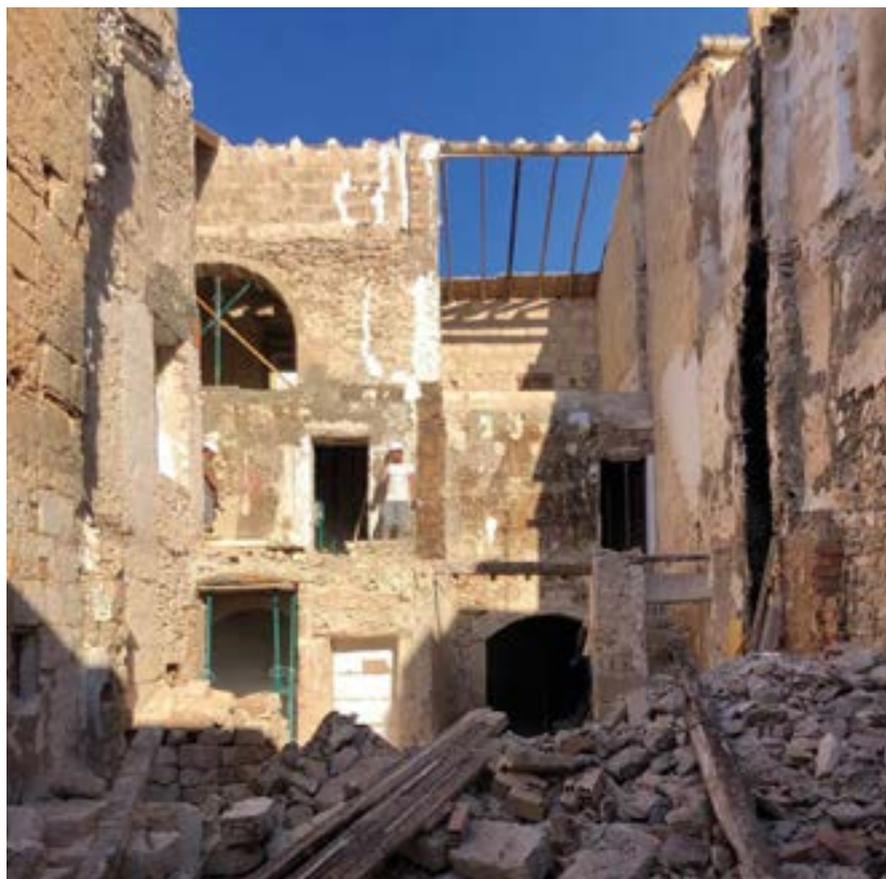
El objetivo de esta obra pasaba por mantener parte de la estructura original del edificio, aprovechando los muros de piedra en un proceso que duró 14 meses. El reto principal fue conseguir sensación espacial de amplitud y continuidad, trabajando la sección, la doble altura y los seminiveles, partiendo de un edificio con espacios muy compactos y oscuros, manteniendo a la vez los elementos fundacionales de la vivienda como los muros de piedra. Tanto para la cubierta como forjado, el estu-
