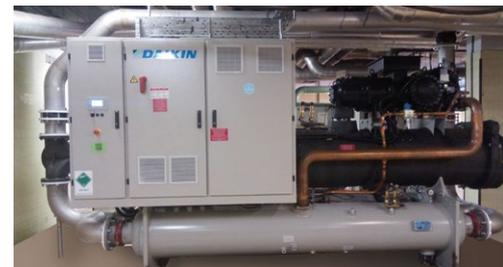
(VVR), un sistema innovador que permite al compresor adaptar la presión de carga del refrigerante a las condiciones de funcionamiento específicas, “lo cual evita las pérdidas de energía producidas por fenómenos de compresión escasa o excesiva”.
