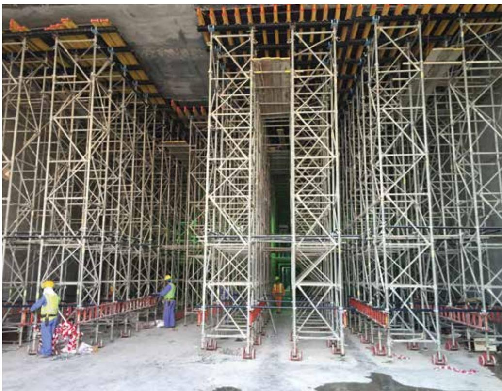
soportar las presiones de hormigonado requeridas. De hecho, la sencillez del sistema ha superado las expectativas del cliente con un gran rendimiento en obra. La losa de 30.000 m<sup>2</sup> de área y 1,8 m de espesor tiene una altura bajo encofrado/
