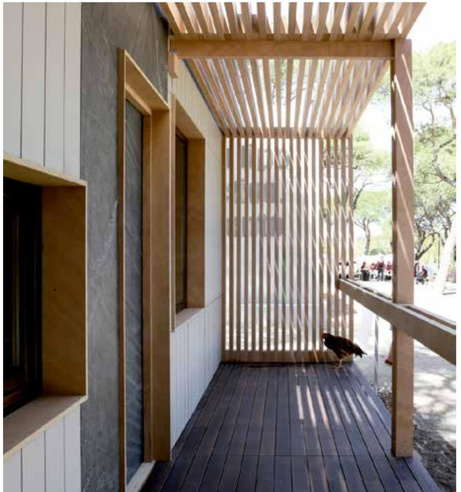
de cemento Aquapanel (GRC), atornilladas en la cara exterior de una estructura metálica formada por maestras CD 60/27/0,7 (W681) o montantes de 0,7 mm de espesor (W 682). Esta estructura metálica va fijada a la construcción original y constituye un soporte para el montaje de las placas.
