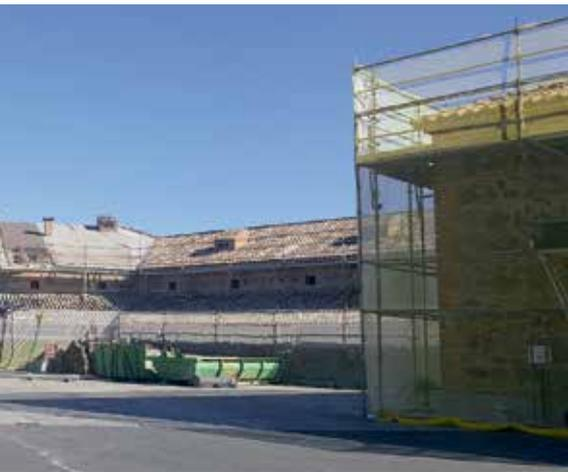
El sistema SATE de Cubierta Onduline ha sido la solución constructiva escogida para la rehabilitación del tejado, por su rápida aplicación directamente sobre el forjado, permitiendo dotar fácilmente al tejado de un aislamiento continuo y garantizando la estanqueidad por 30 años.
