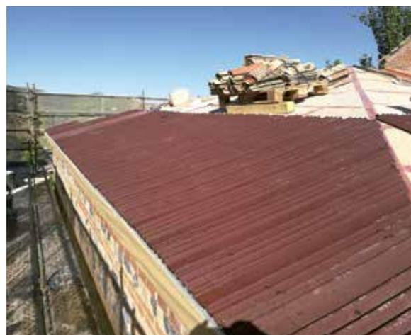
“Las tareas de reparación del tejado han constado de diferentes fases y actuaciones debido a las distintas composiciones existentes entre unas y otras zonas de cubierta. En general, se ha retirado y aprovechado la mayor parte de tejas posibles para su reutilización como tejas cobija”
