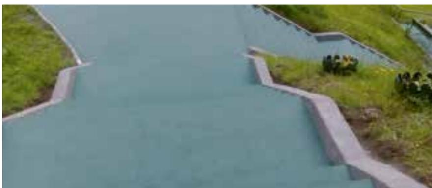
La pavimentación objeto de rehabilitación abarcaba una superficie de 140 m<sup>2</sup> y consistía principalmente en las posiciones de tiro y los accesos a las mismas (incluyendo escaleras); todo ello ubicado en el exterior y, por tanto, sometido a las inclemencias del tiempo.
