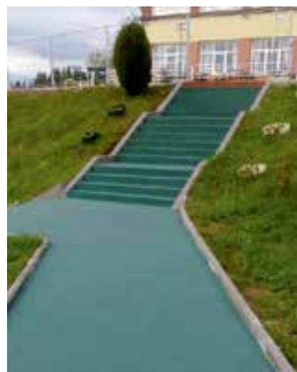
• Una vez aplicada la imprimación, se procede a la obtención del mortero epoxi por adición del árido seleccionado a la mezcla ya homogeneizada de ambos componentes, removiendo
