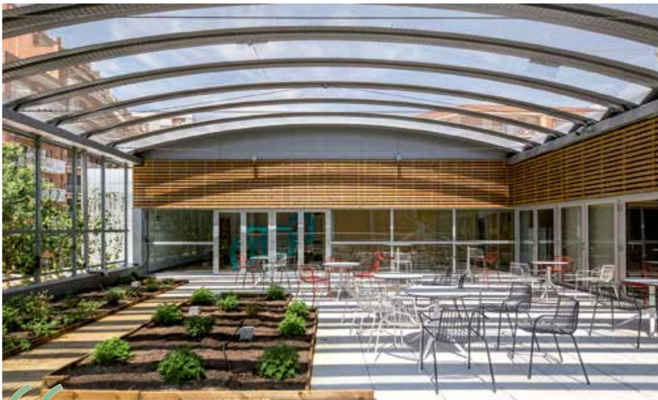
“La cubierta principal del edificio se resuelve mediante tres bóvedas con luces de 12 m, aproximadamente, entre apoyos, por unos 25 m de largo”
