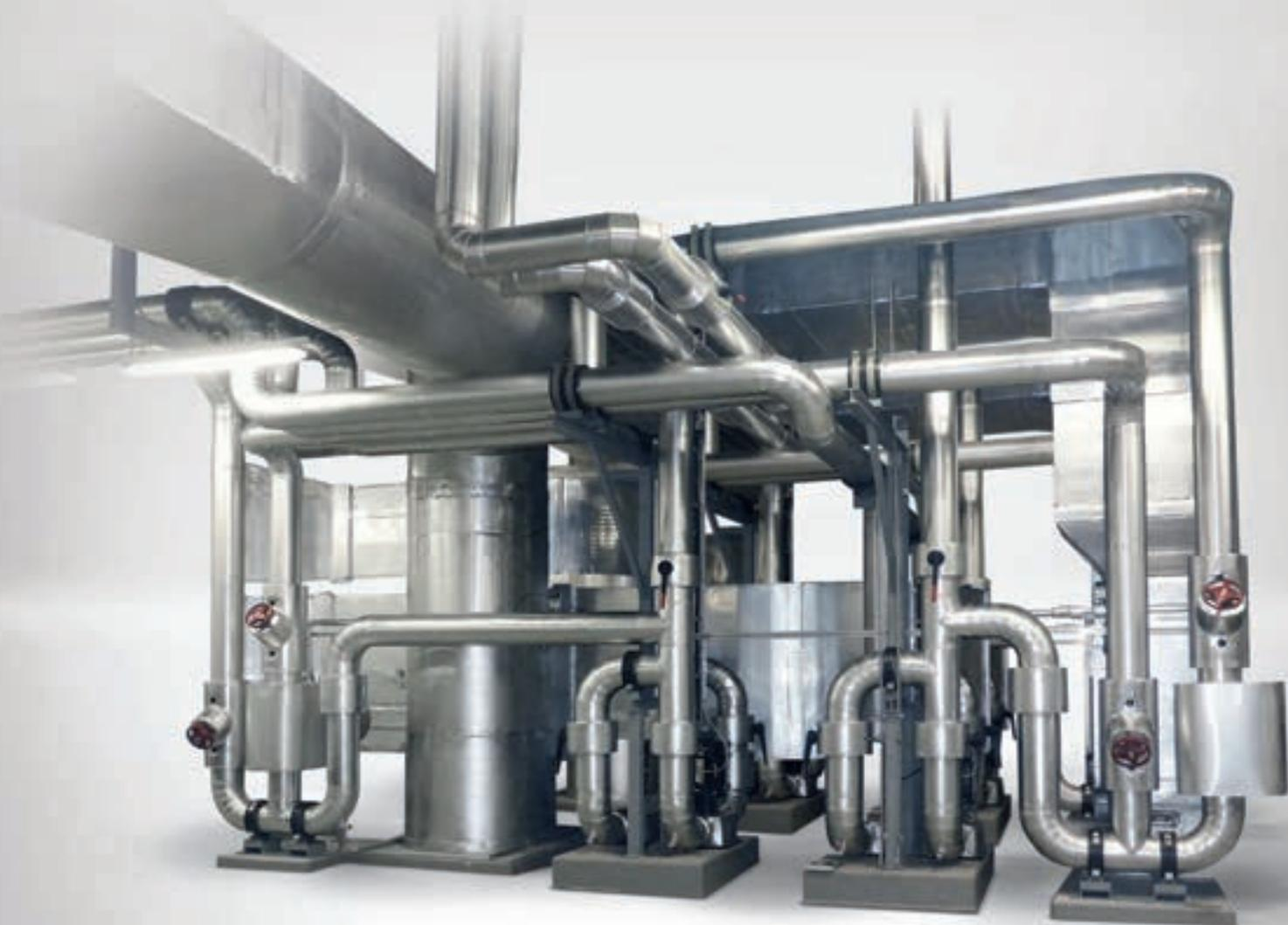
El sistema de recubrimiento brillante con doble lámina de aluminio, está forrado con una protección UV especial y una base de PVC. Arma-Chek® Silver puede ser utilizado tanto para interior como para exterior. En aplicaciones interiores se requieren medidas higiénicas más estrictas (ej. limpieza de sala, industria alimentaria).
