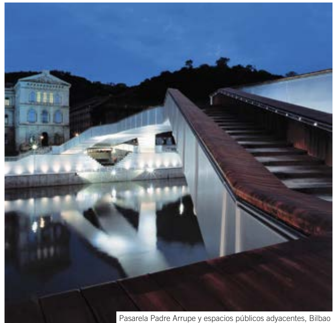
Pasarela Padre Arrupe y espacios públicos adyacentes, Bilbao
