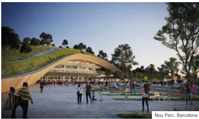
Nou Parc, Barcelona
