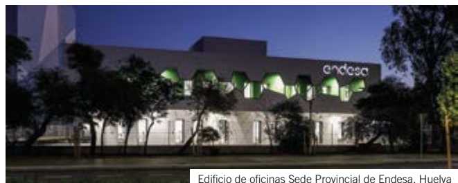
Edificio de oficinas Sede Provincial de Endesa, Huelva
