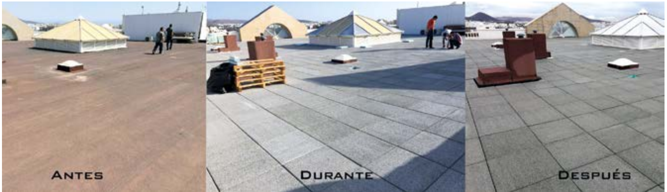
Auditoría energética y posterior proyecto de rehabilitación energética de la Casa Cabildo de Lanzarote.
