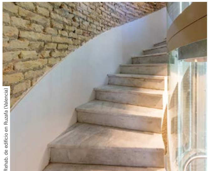
Rehab. de edificio en Ruzafa (Valencia)
