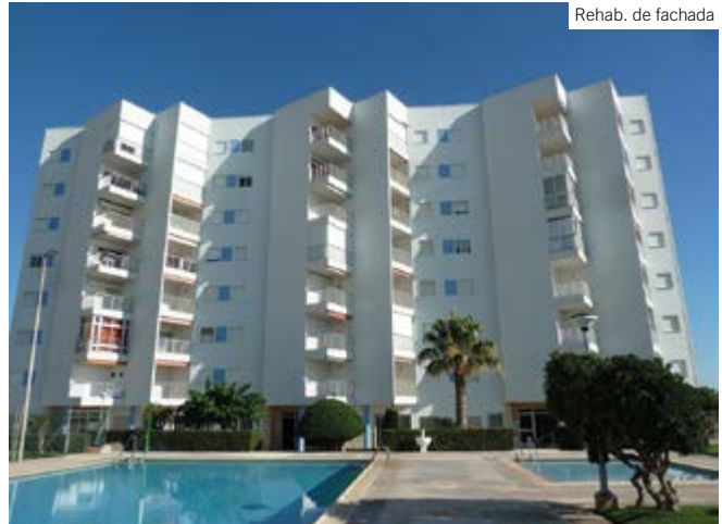
Rehab. de fachada
